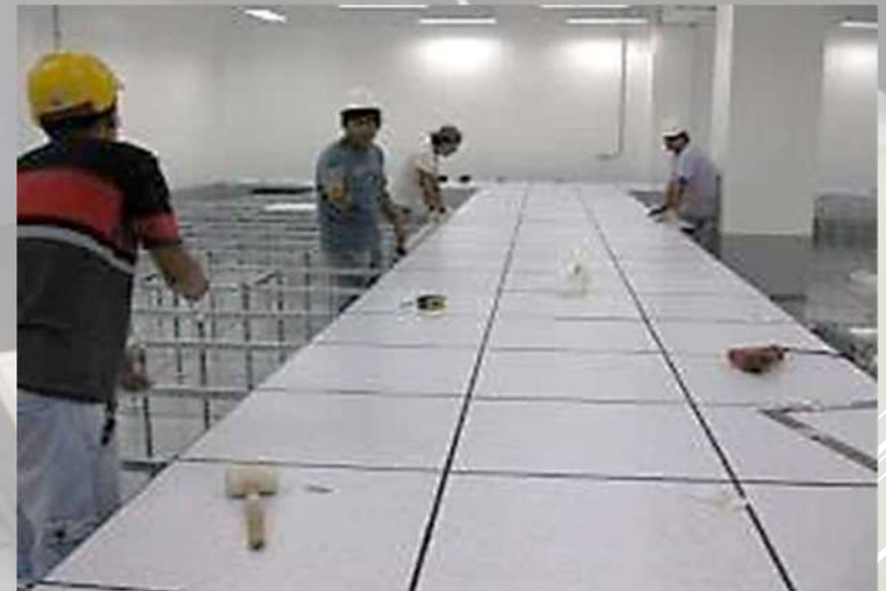
Suministro e Instalación de Piso Técnico
